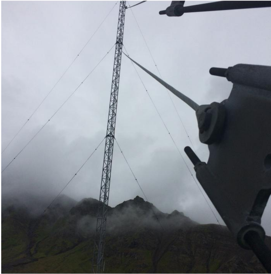
100 metra mastur fyrir Navtex á Sauðanesi við Siglufjörð
